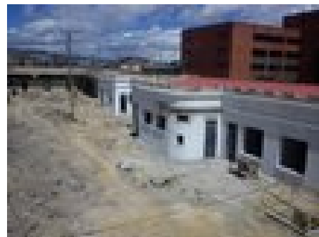
Foto N°10. RECUPERACION VOLUMETRICA PARA ZONA ADMINISTRATIVA E INVESTIGACION
