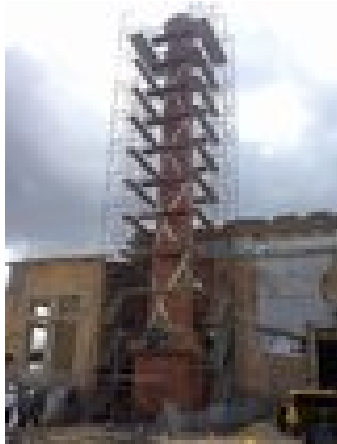
Foto N° 7. RECUPERACION DE CHIMENEA SE REQUIRIÓ REFORZAMIENTO ESTRUCTURAL
